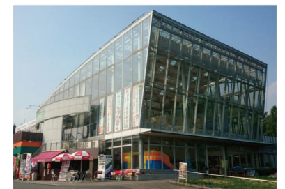
道の駅「おおむた」花ぶらす館
